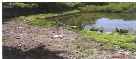
水尾公園の安全柵設置
