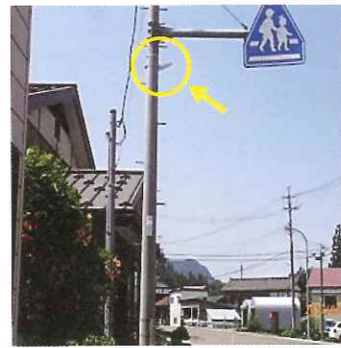
穴地新田防犯灯(LED)の設置
